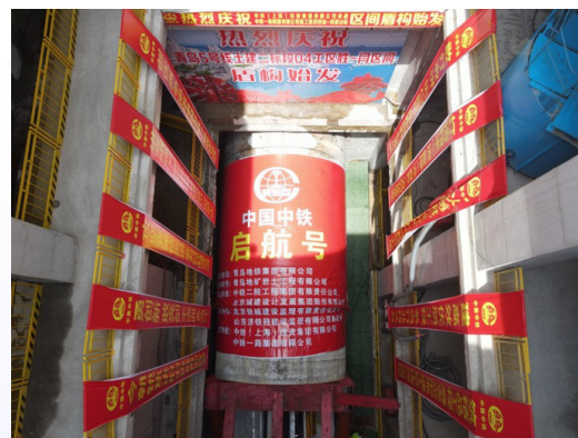
米度助力青岛地铁项目
